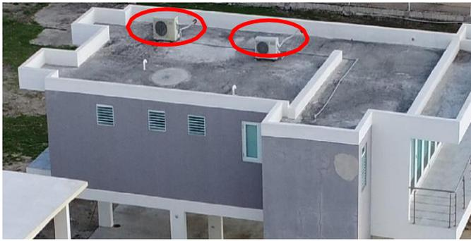
**Imagen 9. Equipo de calefacción, ventilación y aire acondicionado (HVAC) (óvalos rojos) anclado al techo de cemento en Humacao.**
