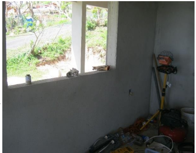
Imagen 3. Terminaciones interiores de cemento típicas en una residencia en construcción en Yabucoa.
