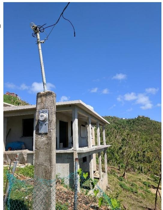
*Imagen 5. Contador eléctrico elevado en un pedestal de cemento en una casa en construcción en Yabucoa.*
