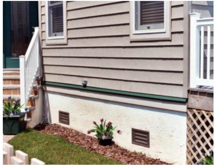
Imagen 6. Ejemplo de aperturas hidrostáticas (círculos rojos). De FEMA TB-1 (imagen de portada).
