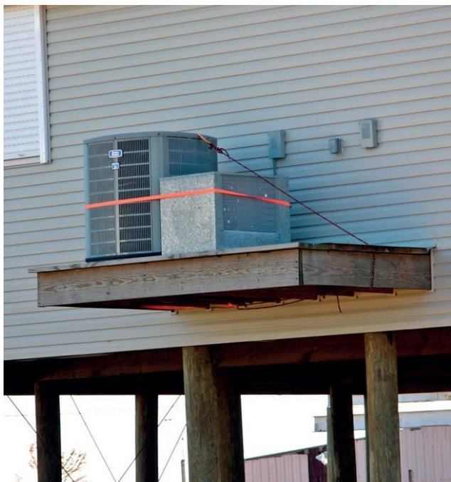
Imagen 7. Plataforma en voladizo para elevar un compresor de aire acondicionado y protegerlo de la inundación. De la guía FEMA P-348 (Imagen 3-2).
