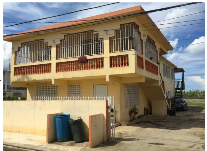
Imagen 2. Estructura residencial típica con armazón y techo de cemento en Vega Baja.
