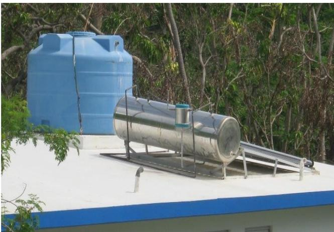
*Imagen 4. Calentador solar de agua y tanque de agua anclados en un techo de cemento en Rincón.*
